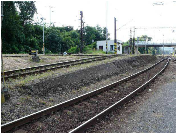
V rámci stavby dojde k odstranění stávající kolejové brzdy a svážného pahrbku.
